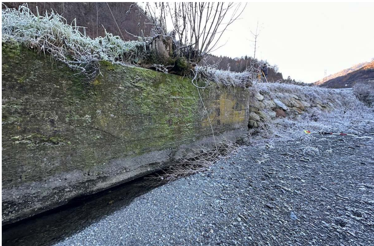
Figura 3 - muro d'argine in calcestruzzo non rivestito
