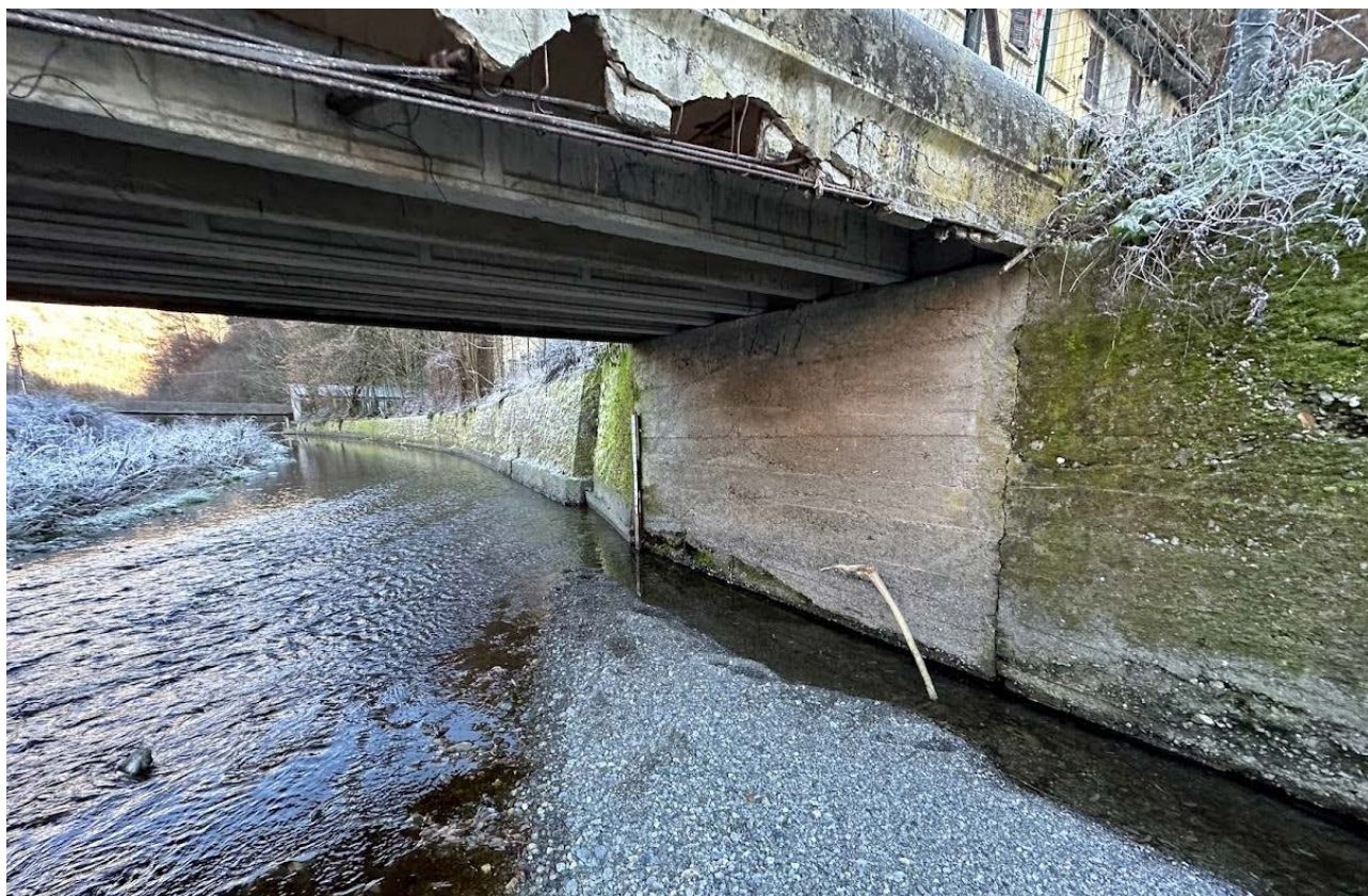
Figura 4 Spalla del ponte ed argine, in calcestruzzo non rivestito
